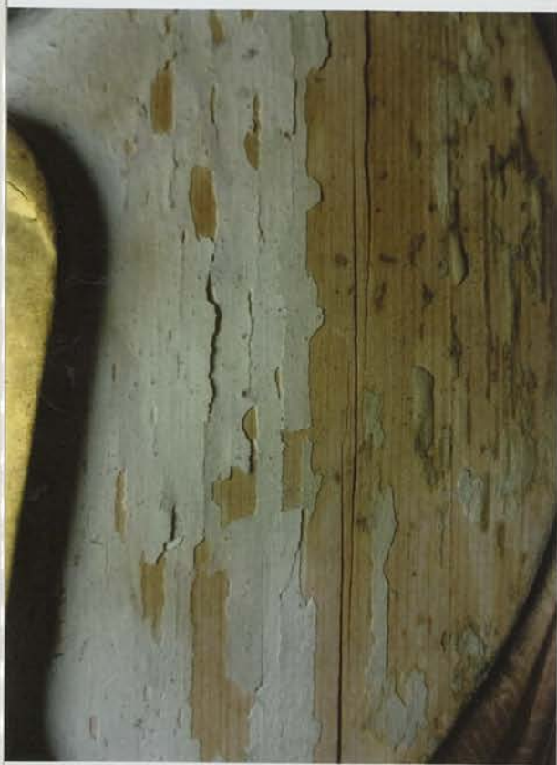
28、光背周縁部 彩色浮き上がり状況
