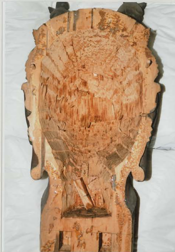
37、頭部後面材内剝り部 納入状況
