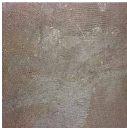
写真5 表からの補修
