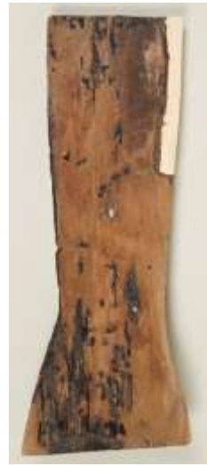
左側面裳裾材 補作状況
