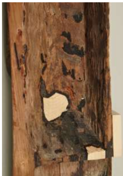
左側面材 補作状況
