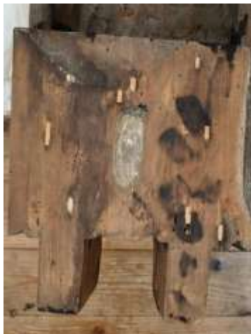
軀幹中間材 亡失箇所及び虫蝕朽損箇所及び鉄釘穴の補作
