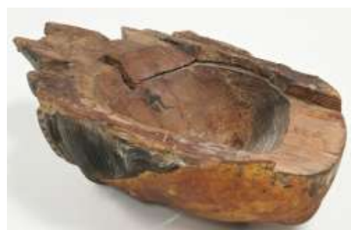
頭部正面材 干割れ状況
