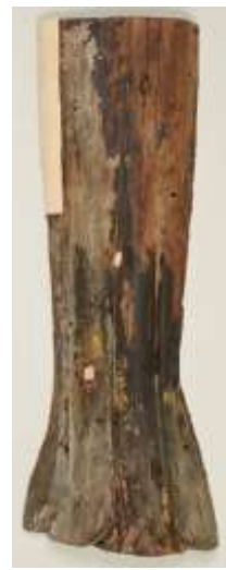
左側面裳裾材 補作状況
