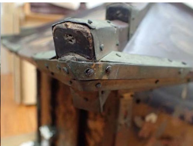
30. 修理後 屋蓋 新調した鉋を打った状態
