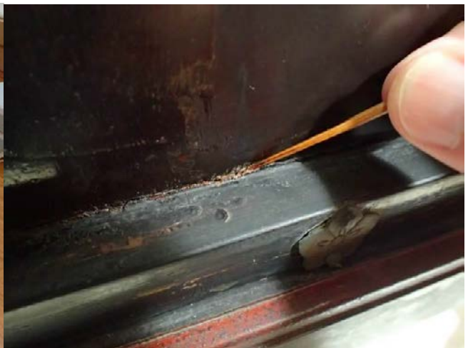
22. 修理中 亀裂に刻苧漆を充填している様子
