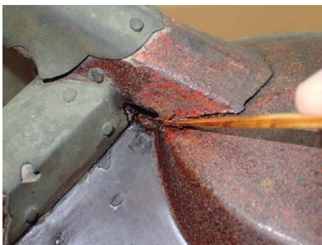
2 7. 屋蓋棟の亀裂に刻苧漆を
