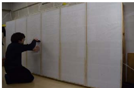
[ 下張り作業(浮け掛け) ]
