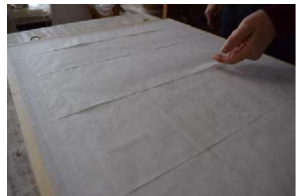
[ 下張り作業(蓑掛け後) ]
