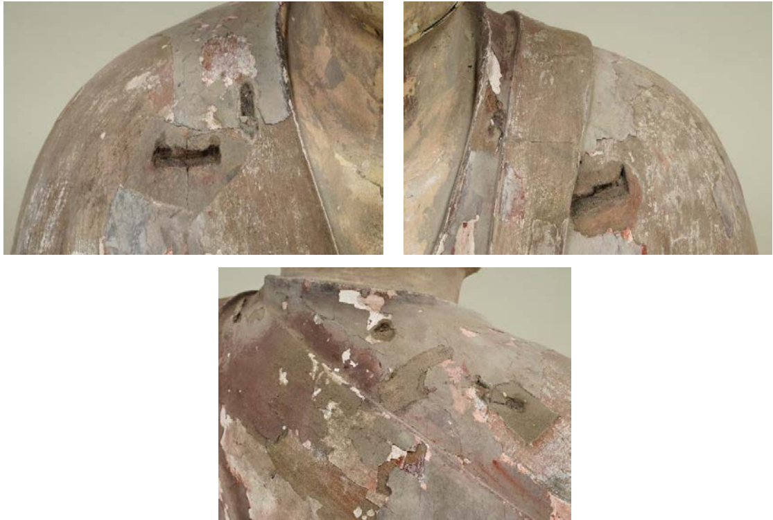
矧目に打ち付けられた鉄釘・鋸の腐食
